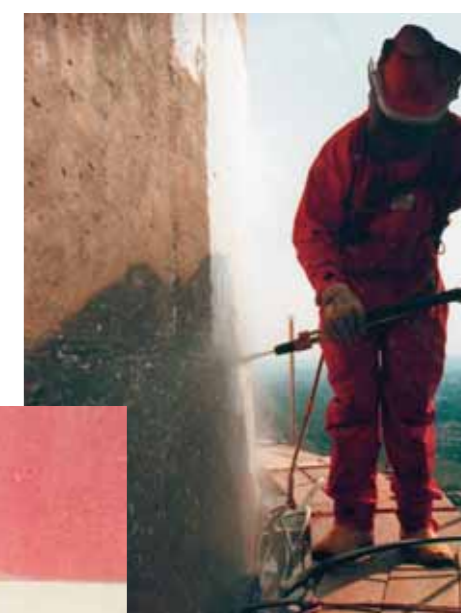
Abtragen von alten Farbanstrichen mit TORNADO Wasser-Sandstrahl-System im Kaltwasser-Hochdruckbetrieb
