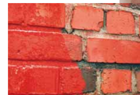
Entfernung von Altfarbe mit HIP Flachstrahldüse und überhitztem Hochdruck-Wasser
