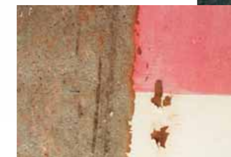
Abtragen von alten Farbanstrichen mit TORNADO Wasser-Sandstrahl-System im Kaltwasser-Hochdruckbetrieb
