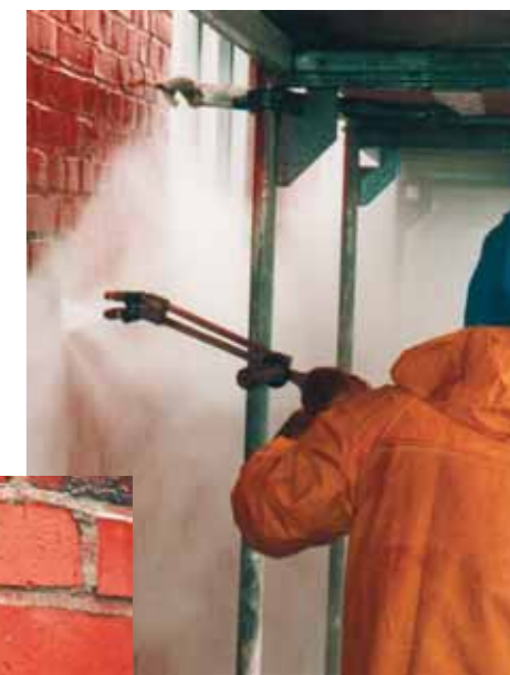
Entfernung von Altfarbe mit HIP Flachstrahldüse und überhitztem Hochdruck-Wasser
