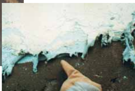
Entfernung elastischer Anstriche mit TURBOFRÄSER-Düse und heißem Hochdruck-Wasser
